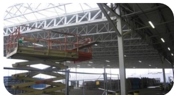
FAURECIA ROZBUDOWA ZAKŁADU PODZESPOŁÓW SAMOCHODOWYCH, GORZÓW
