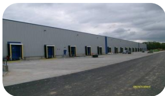
MICHELIN BUDOWA CENTRUM LOGISTYCZNEGO W PRUSZKOWIE
