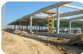
INDESIT RADOMSKO BUDOWA FABRYKI I MAGAZYNÓW
