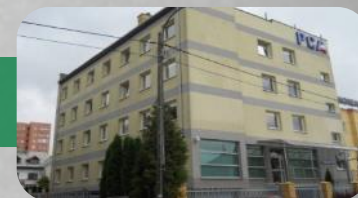
BUDYNEK BIUROWY POLSKIE CENTRUM AKREDYTACJI WARSZAWA
