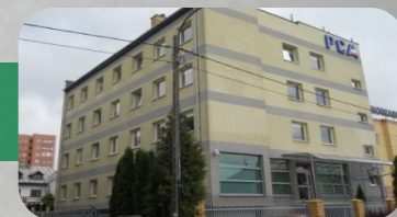
BUDYNEK BIUROWY POLSKIE CENTRUM AKREDYTACJI WARSZAWA
